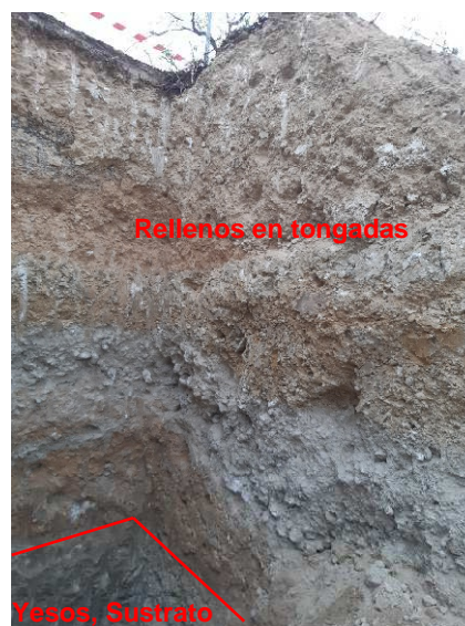
Excavación del batache del Pilar 62. Relleno en tongadas sobre el terreno natural
