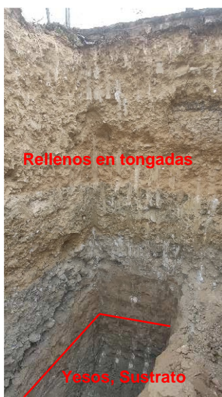
Excavación del batache del Pilar 62. Relleno en tongadas sobre el terreno natural
