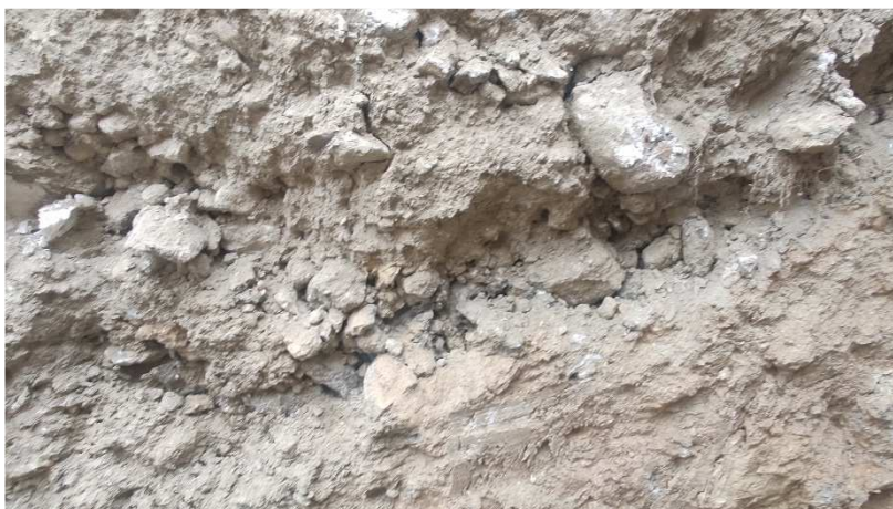
Detalle de los huecos en la tongada de bloques de yeso
