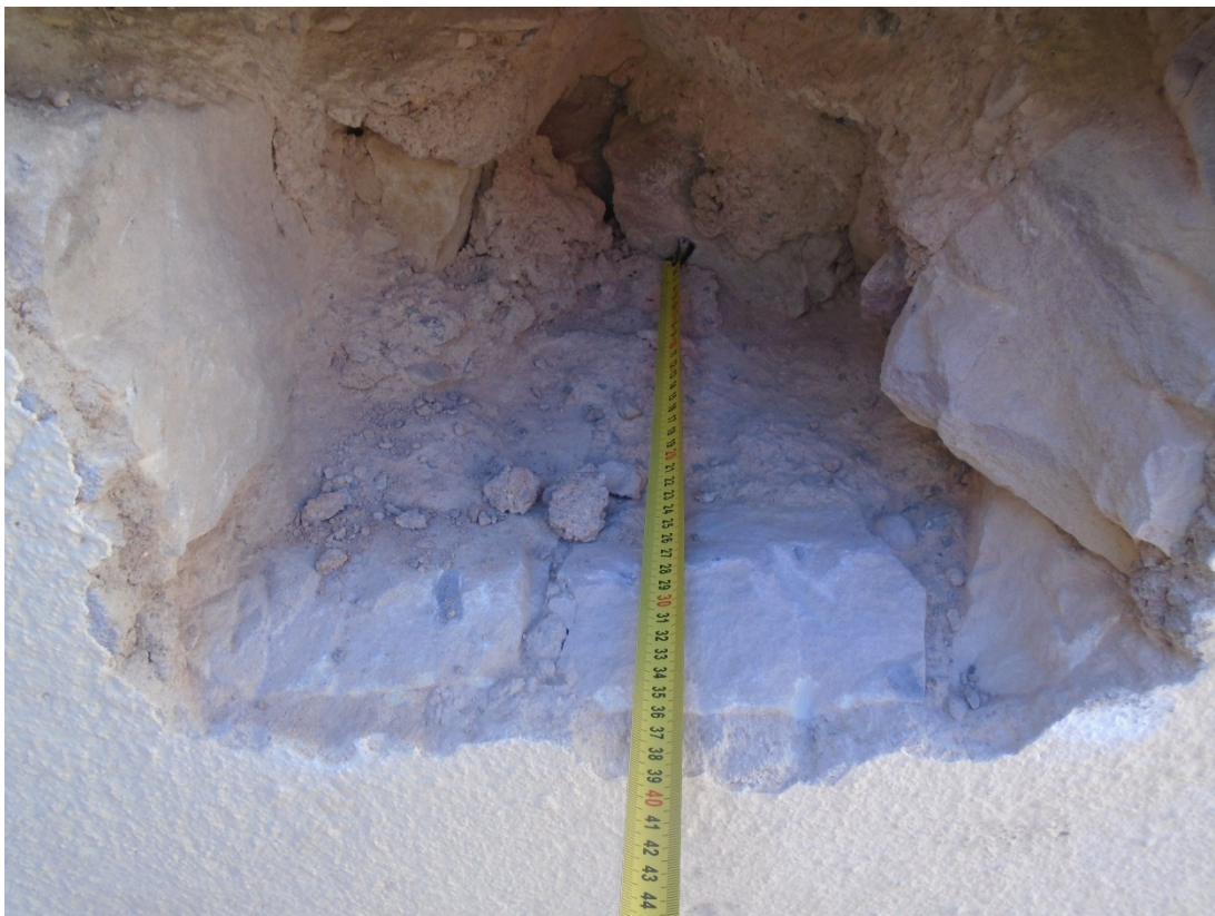
Foto 5: Roza R2, en el muro C, se aprecian los mampuestos y morteros en buen estado.
