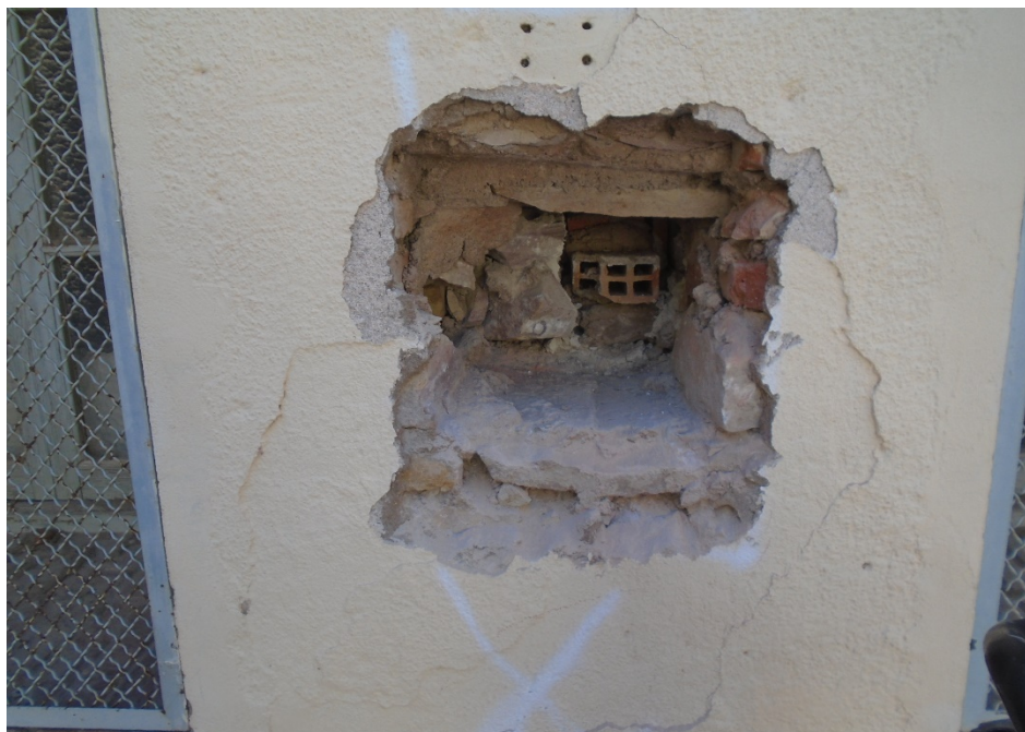
Foto 2: Vista frontal de la roza R1 en el alzado de muro del eje 6. Muros de mampostería a base de bloques paralelepípedos de entre 25 cm y 35 cm constituidos por areniscas rojizas
