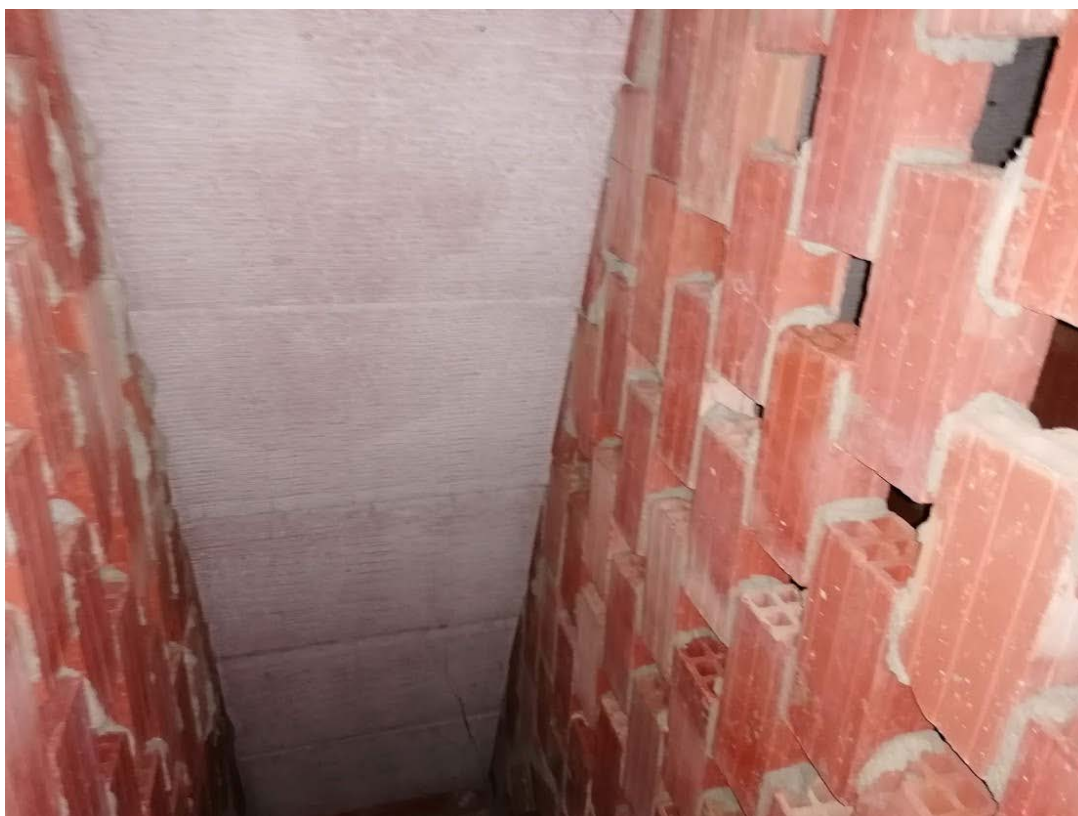
Foto 19: Tabiques palomeros en formación de la pendiente de la cubierta y el bardo de soporte de las tejas.
