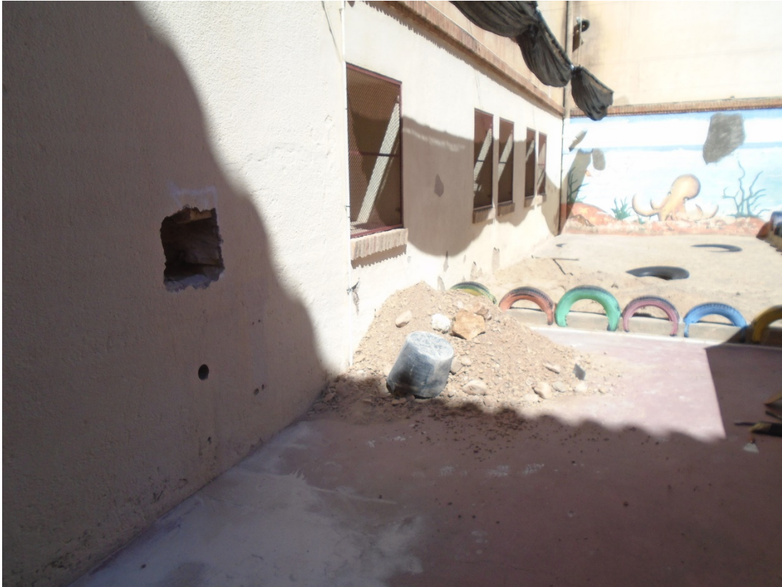
Foto 4: Emplazamiento de roza R2 y testigo de muro TM2, en el muro C.
