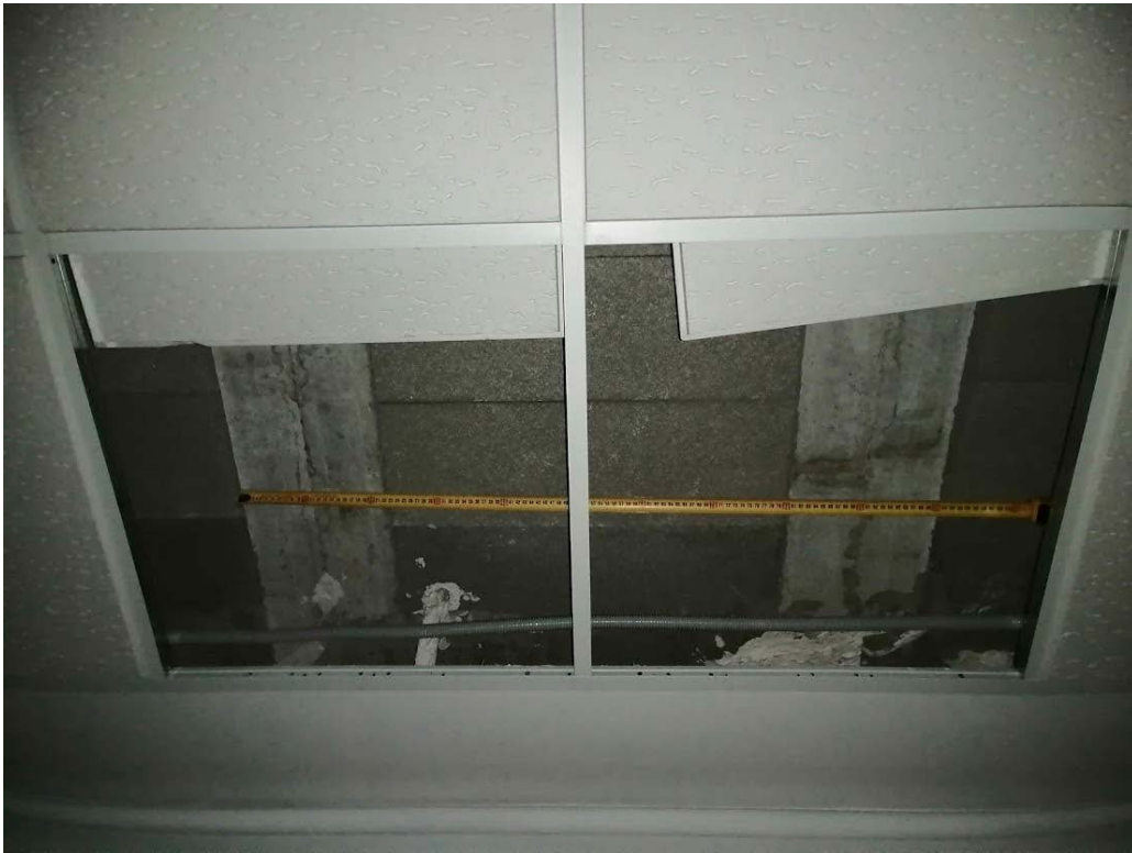
Foto 13: Forjado 1 sobre el comedor en la zona de luz libre de 6,48 m. Doble vigueta de 11 cm de ala inferior y bovedilla de hormigón de 58 cm de ancho inferior. Ancho total 100 cm e intereje 78 cm. Ejes de apoyo en los ejes A y B.
