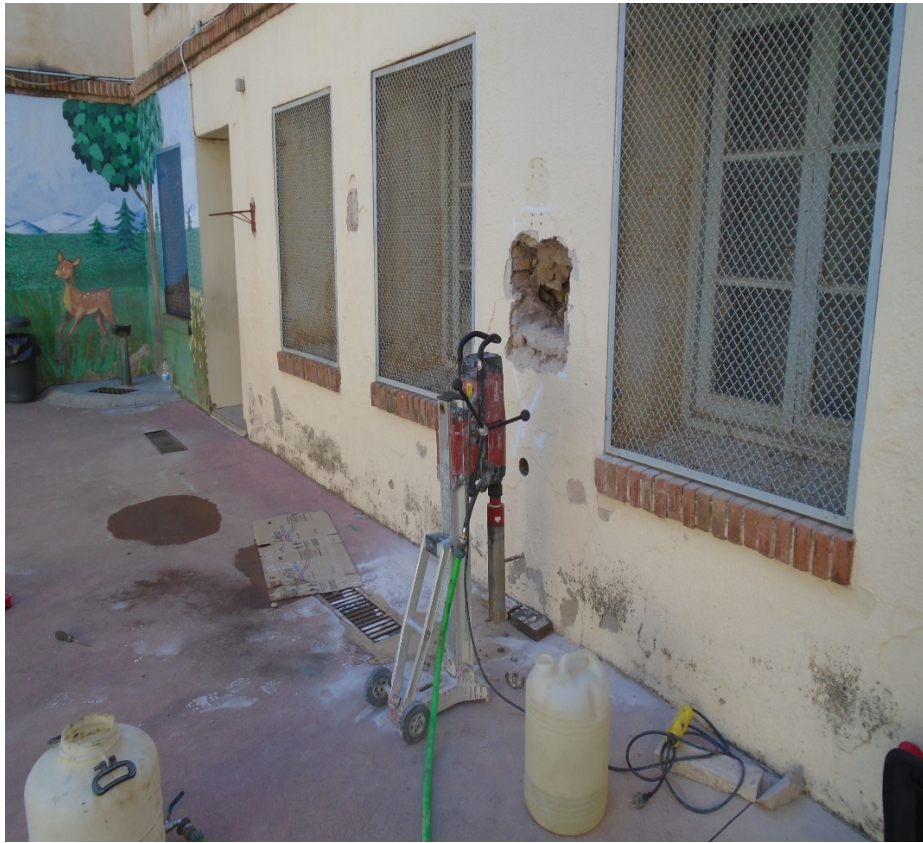
Foto 1: Roza y testigo de muro (R1+TM1). Eje 6.
