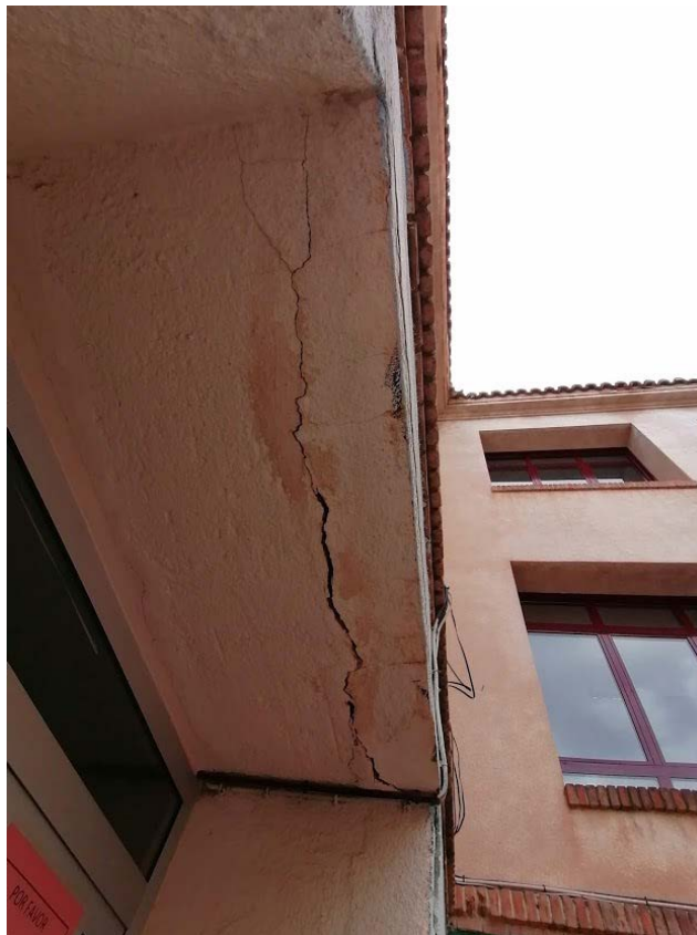
Foto 25: Alzado del eje D. Zona del dintel de la puerta y ventanas en mal estado.
