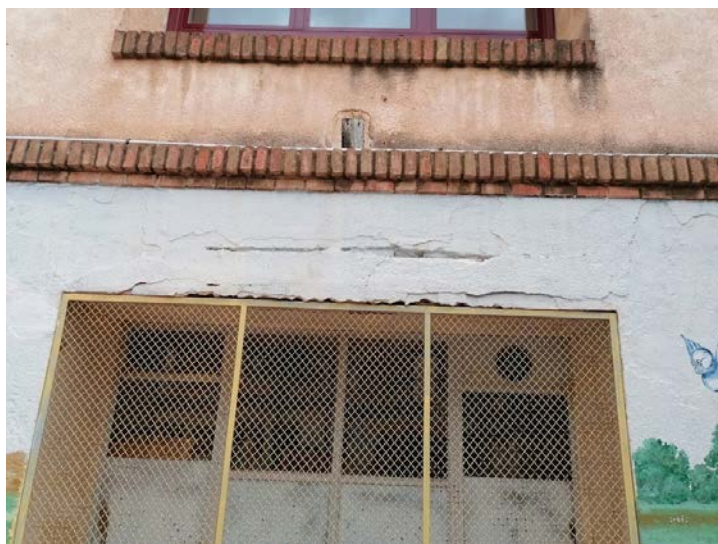
Foto 26: Alzado del eje D. La zona interior del dintel de la ventanas también presenta grietas y fisuras.
